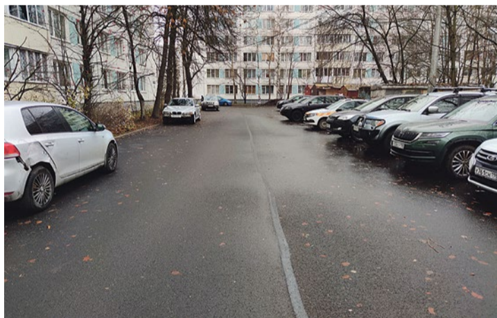
Замена асфальта, Софийская улица, 41/2
