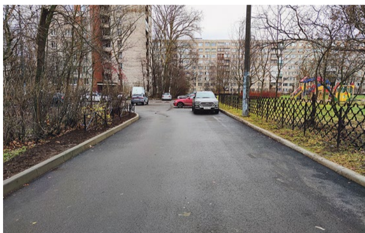
Замена асфальта, Софийская улица, 32/1
